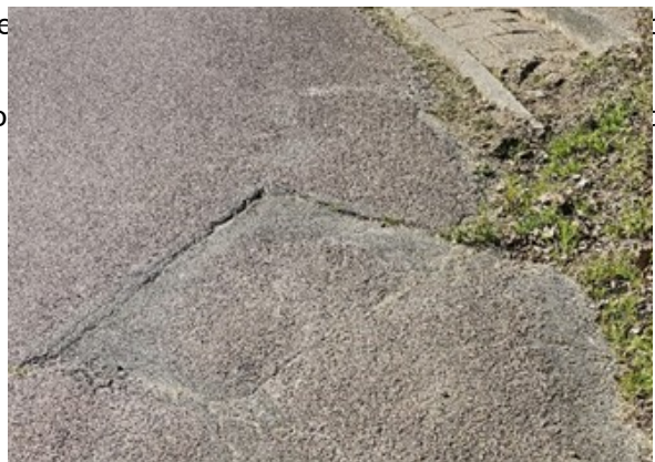
Fietstunnel noordelijke Rondweg Oostzijde
