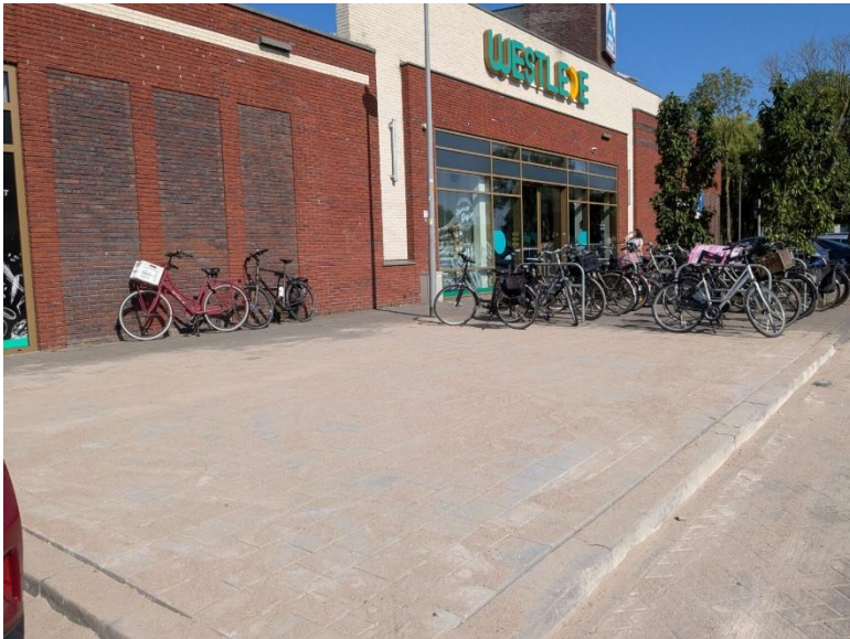
Extra ruimte voor fietsenstalling bij Westlede in voorbereiding
